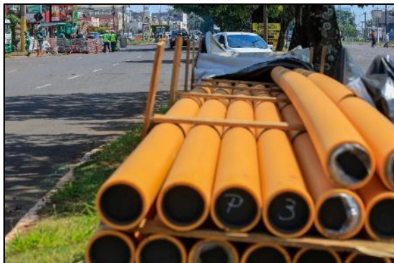
Obra de implantação de novas redes
