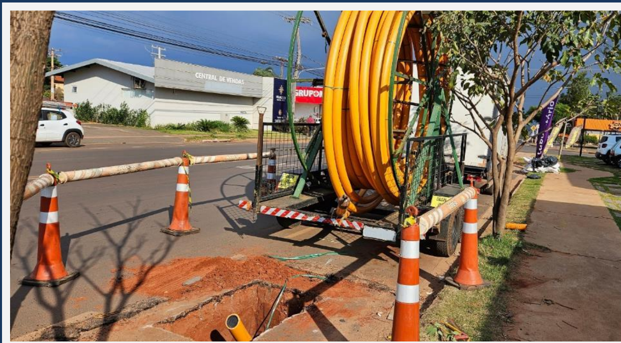
Obra de Expansão de Rede de Gás Natural
