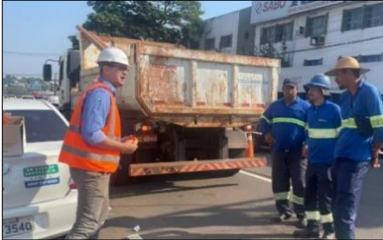
Visita de monitoramento de SMS em obras
