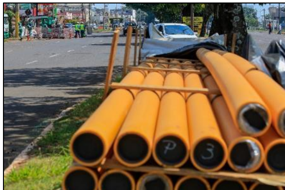
Obra de implantação de novas redes
