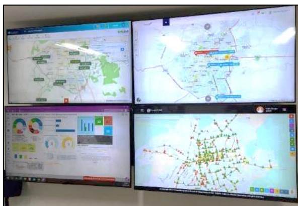
Painel de monitoramento do sistema de distribuição
